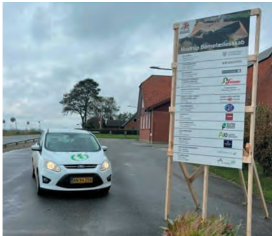
Sommer 2024 startede renovering af Nustrup skole hvor TA Elteknik ApS står for alle elinstallationer.
